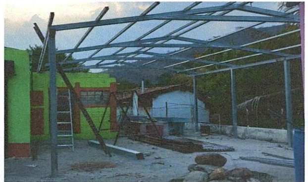
Foto 2: Mejoramiento de techo de cocina.
