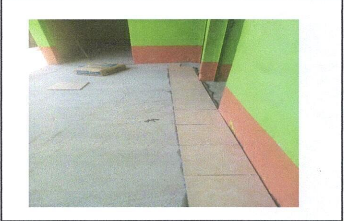
Foto 4: Mejoramiento de piso de aula.
