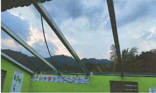
Foto 1: Mejoramiento de techo de aula.
