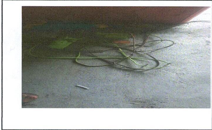
Foto 1: Mejoramiento de sistema electrico del edificio escolar.
